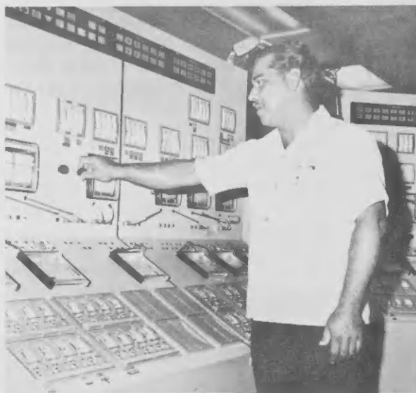
Antonio G. Geerman, Panel Operator di Light Ends na Refinery Operation Controlhouse aki ta injecta steam den e sistema di flare pa reduci emission di huma.
